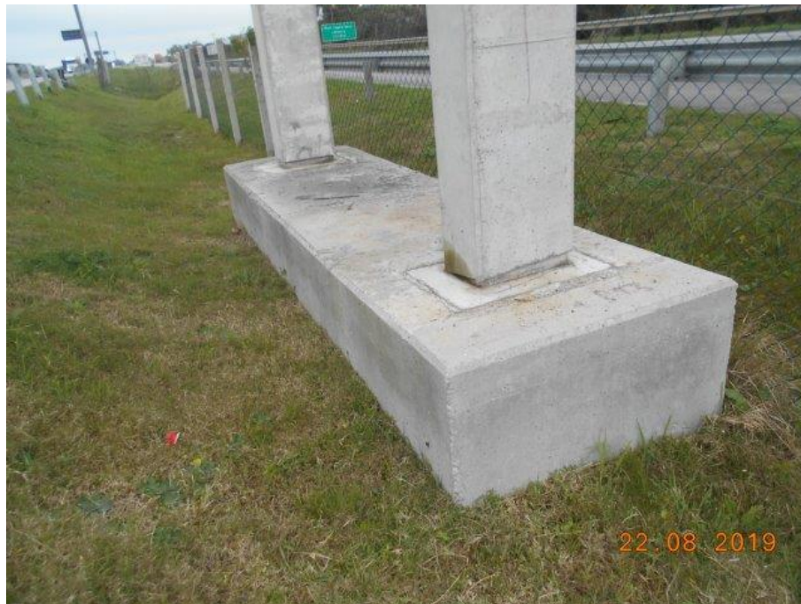
Foto 57 Vista do bloco de fundação do apoio AP4.
