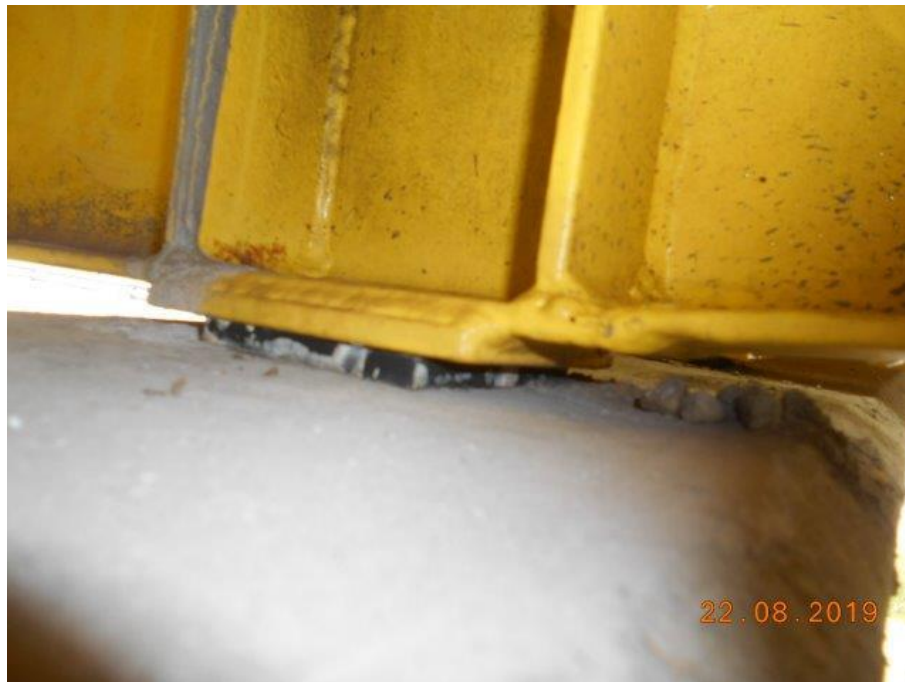
Foto 13 Vista do aparelho de apoio AA2 em bom estado.
