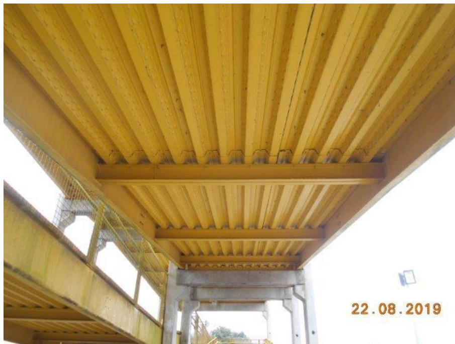
Foto 10 Vista inferior da rampa Oeste.
