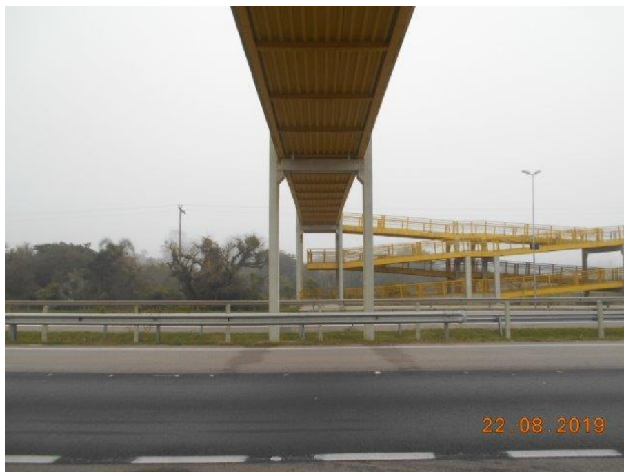
Foto 58 Vista da linha de apoio central AP4. Nota-se defensas metálicas como dispositivo de proteção dos pilares.
