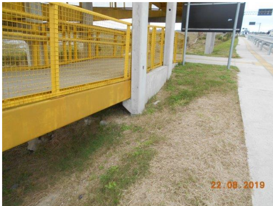
Foto 48 Vista da estrutura de encontro Leste, face Oeste.
