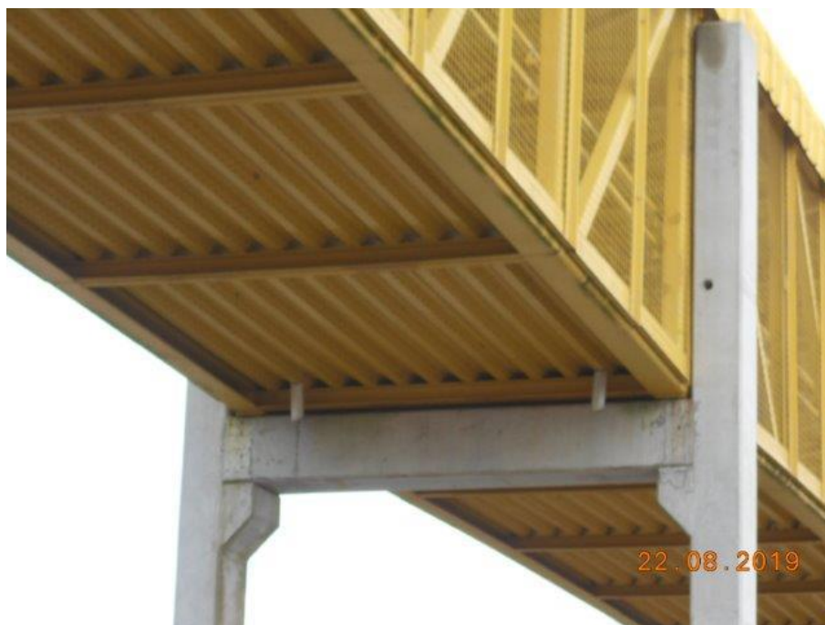
Foto 60 Vista inferior do dispositivo de drenagem.
