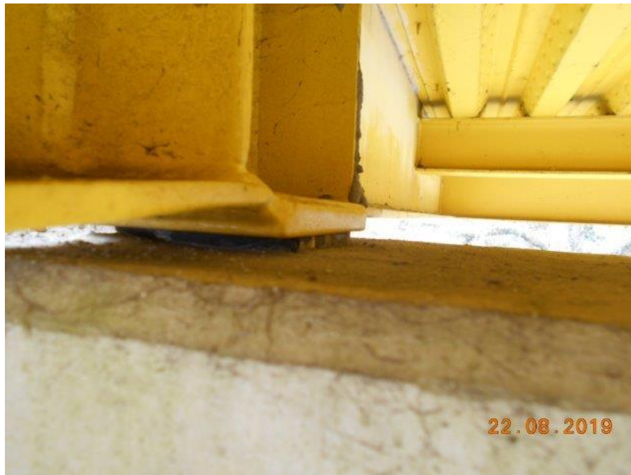
Foto 17 Vista do aparelho de apoio AA12 em bom estado.
