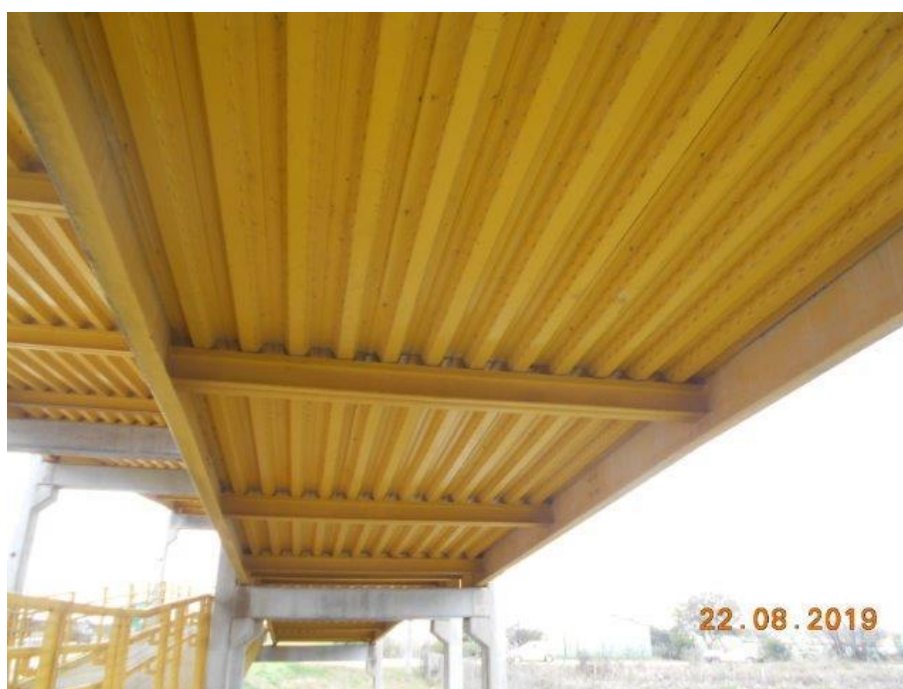
Foto 12 Vista inferior da rampa Leste.
