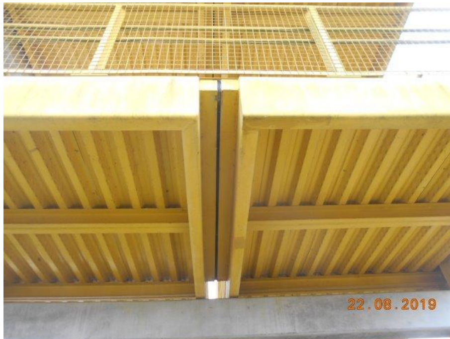
Foto 55 Vista da junta entre o patamar do vão 13 com o vão 14.
