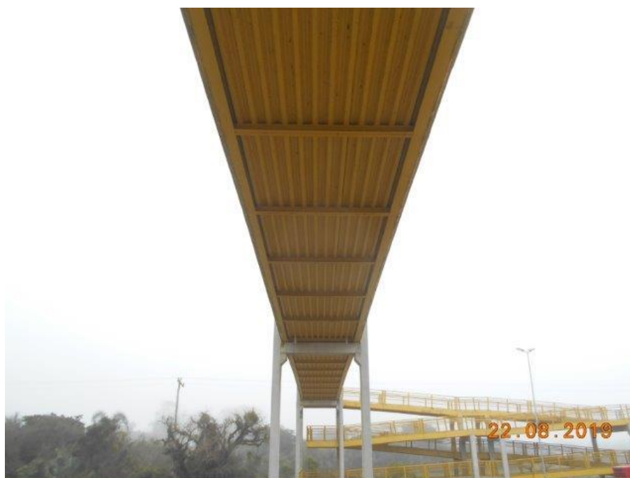
Foto 11 Vista inferior da travessia principal.
