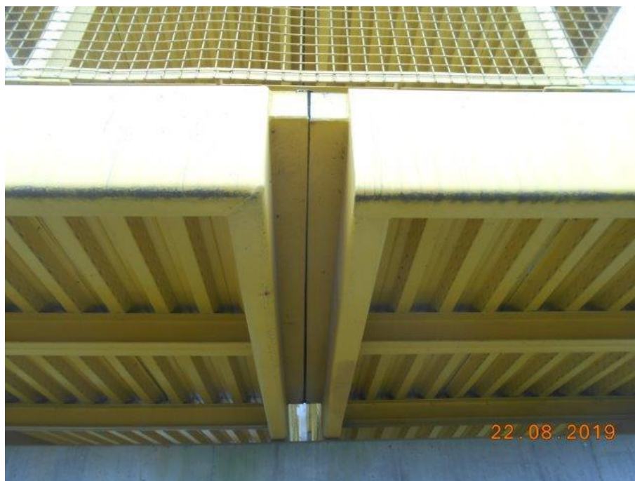
Foto 56 Vista da junta entre o patamar do vão 15 com o vão 16.
