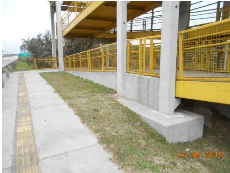
Foto 47 Vista da estrutura de encontro Oeste, face Leste.
